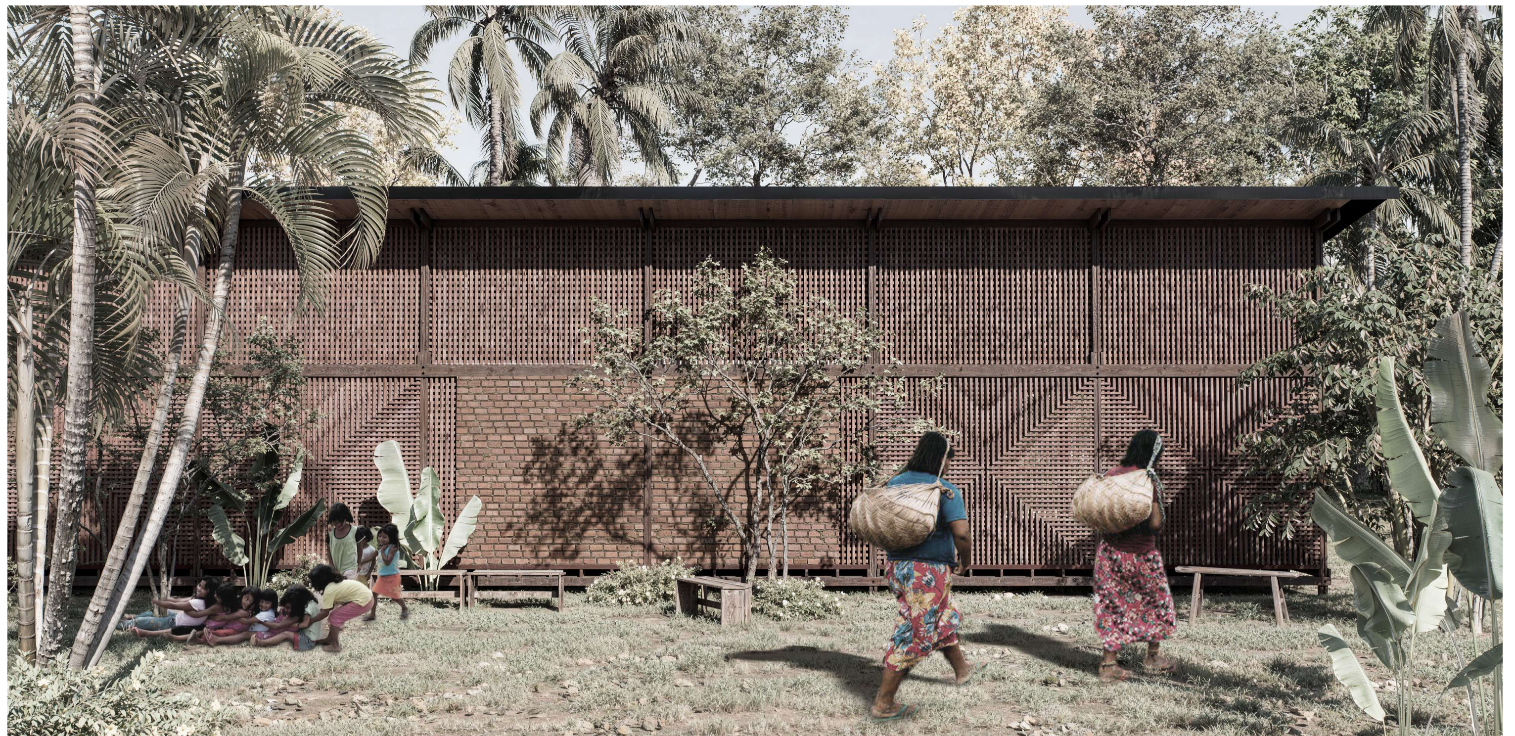
Vista externa típica dos pavilhões com fechamentos em muxarabis e paredes em tijolos maciços. CAMI Referência, Amazônia e Cerrado.
