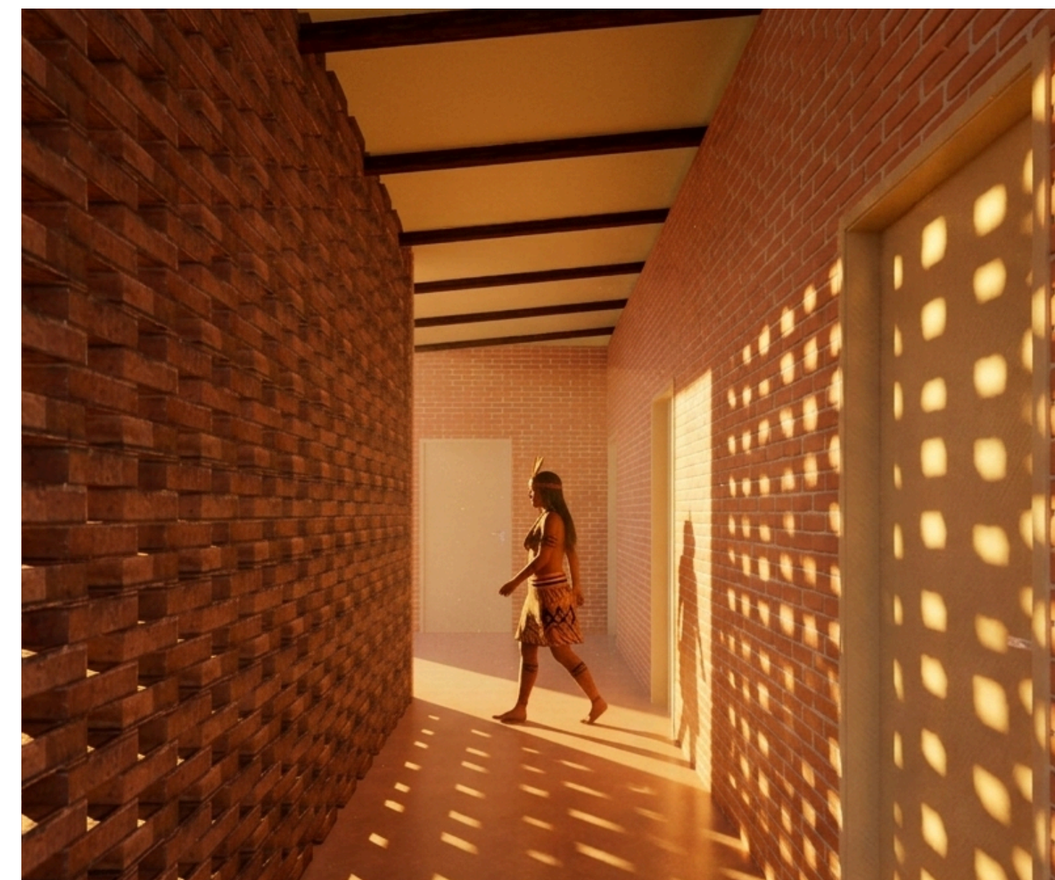
PAREDE COBOGÓ TIJOLO SOLO-CIMENTO NO PÁTIO CENTRAL
